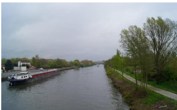
Figure 2: Canal de l'Escaut- Denain- Antea Group
