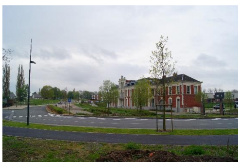
Figure 16 : Faubourg du Château à Denain - Antea Group
