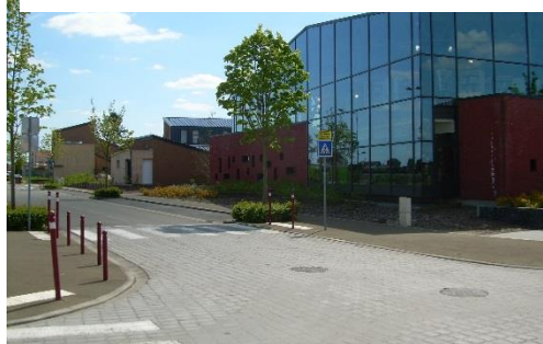
Figure 17 : Médiathèque - Escaudain - Antea Group
